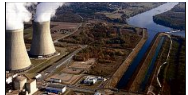
Une vue du canal d'aménée long d'un kilomètre (à gauche) et du canal de rejet des eaux en Loire.
