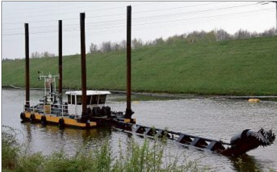
Une drague cure le canal d'aménée de la centrale de Dampierre-en-Burly jusqu'à fin avril, rejetant en Loire 1.300 m 3 par jour de sédiments.
